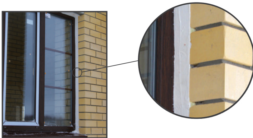
Рисунок 2. Внешний вид наружного слоя монтажного шва, выполненного герметиком Стиз А с идентифицирующими метками
